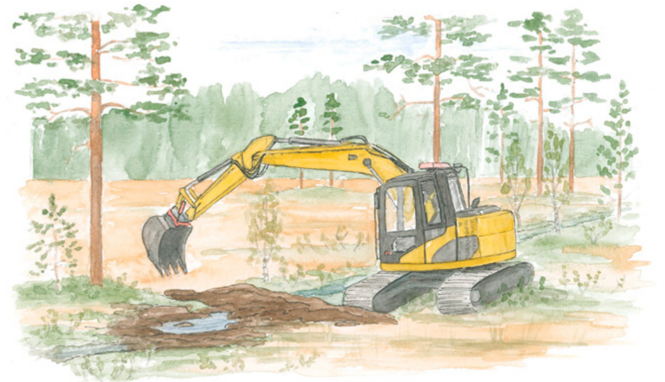
Vattennivån höjs genom dämning av diket. Illustration: Lotta Ström.
