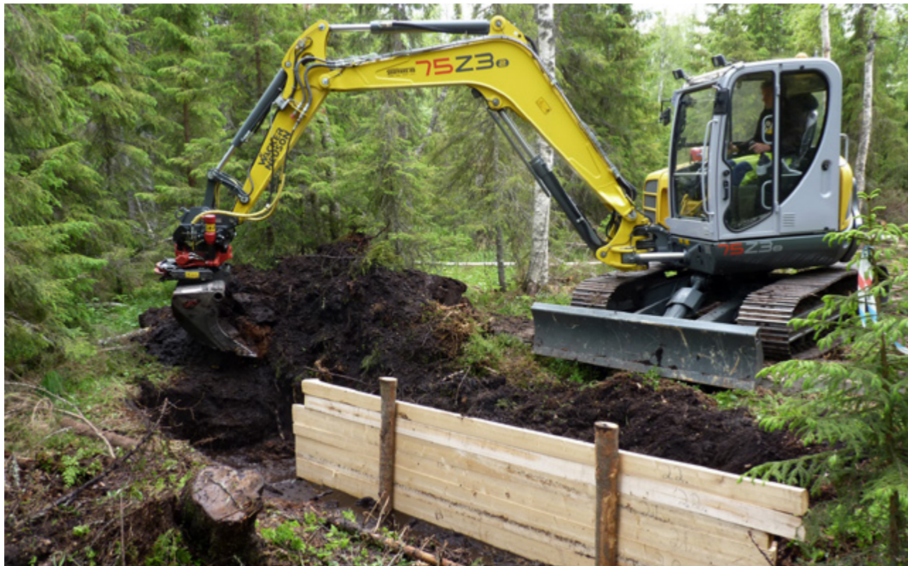
På Gideåbergsmyrarna i Västernorrlands län provades metoden att bygga dämnen av plankor. Slutsatsen är att det inte är en kostnadseffektiv metod. Foto: John Granbo.
