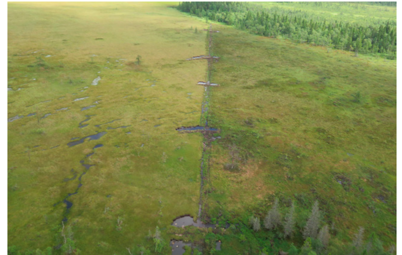
Dike i Koppången, Dalarnas län. Diket har skurit av den naturliga vattenrörelsen från vänster till höger i bilden, vilket gjort att marken till höger om diket är torrare och har mer ris- och buskvegetation. Diket har dämms med jämna mellanrum för att återskapa det ursprungliga vattenflödet. Foto: Urban Gunnarsson.
