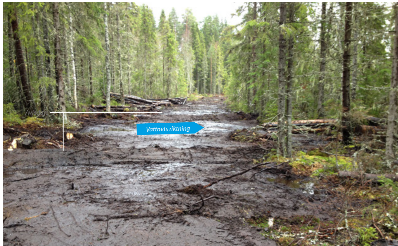
Igenlagt dike i Haftahedarna i Dalarnas län. Ovanpå igenläggningsmassorna har tvärgående avledare byggts för att styra vattenflöden bort från den gamla dikesfåran. Foto: Fredrik Lundin.
