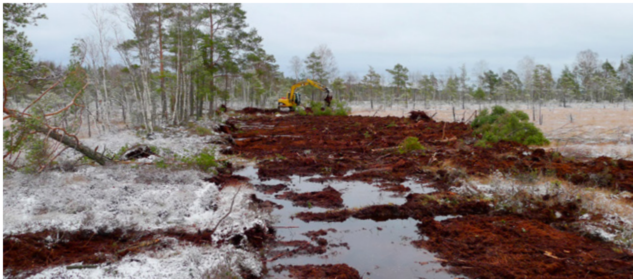
Ena halvan av en torr plint håller på att schaktas ned i Store Mosse nationalpark. Foto: Johan Rova.
