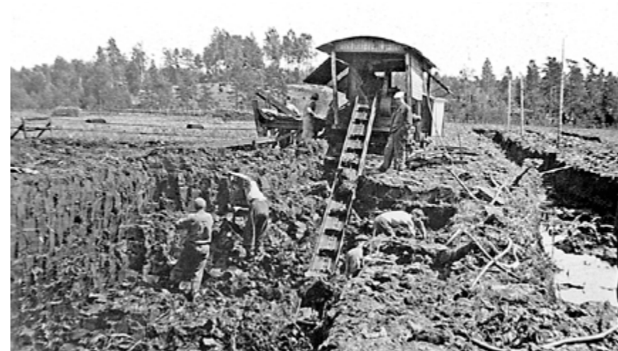
Pågående torvbrytning på Anderstorps Stormosse någon gång under 1940-talet. Torven bryts i långa fåror, så kallade torvgravar, och transporteras upp med ett transportband. Bilden tillhör Maj Johansson. Fotograf okänd.
