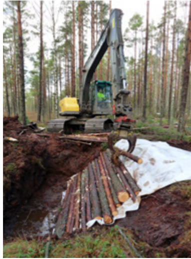
Dämme som byggs med en kärna av liggande stockar och fiberduk. Diket leder sidledes i bilden. Foto: Johan Rova.
