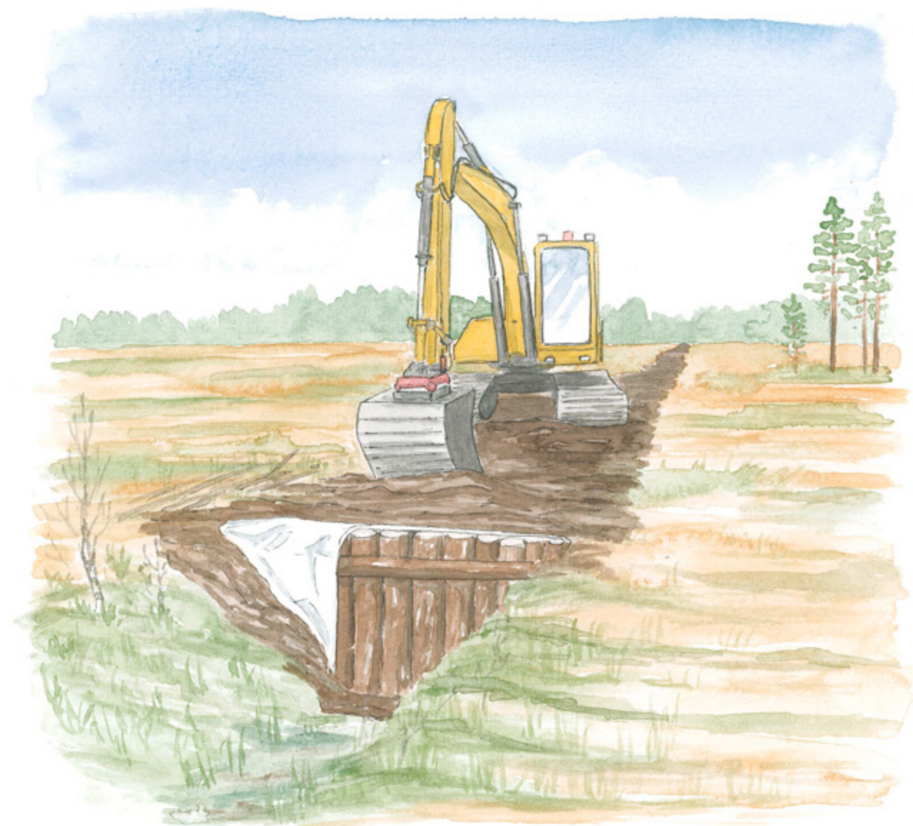
Dämmen kan byggas med en kärna av stockar som sedan täcks med geotextilduk och torv. Illustration: Lotta Ström.
