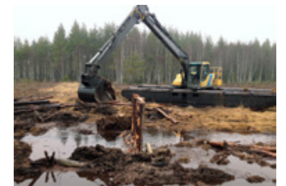
I Kärnskogsmossen i Östergötland användes flytande grävmaskiner med mycket långa band som löper runt flytpontoner, för att komma ut till de platser där dämmen skulle byggas. Foto: Mikael Burgman.
