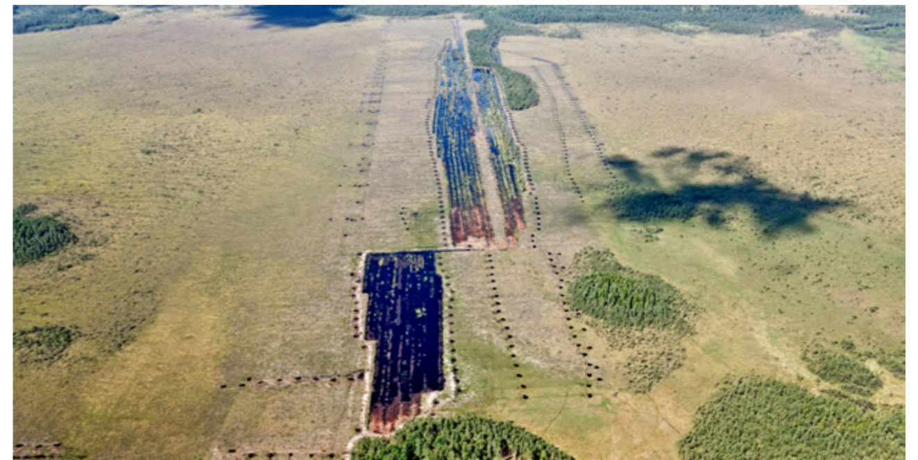
Samma område som ovan år 2015, efter restaurering. Träden är borta. Dikena har täppts igen med dämmen. Vid varje dämme syns en vattenfylld grop där massor har tagits för att bygga dämmet. De torra plintarna har schaktats ned och därefter har vattennivån i torvgravarna höjts. Längst borta i andra änden av täkten har en skogsridda sparats intill en gammal bäckfåra som i och med restaureringen åter har fyllts med vatten. Foto: Bergslagsbild AB.
